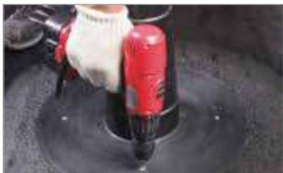
– Закрепите кровельный аэратор в основании, используя минимум 4 крепежных элемента. В качестве крепежных элементов применяйте остроконечные саморезы ТехноНИКОЛЬ EDS-S 4,8 с полиамидной гильзой.
