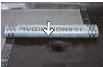
– Наплавьте верхний слой из материала Техноэласт ЭКП (см.п.3.2.2 «Наплавление верхнего слоя»).
