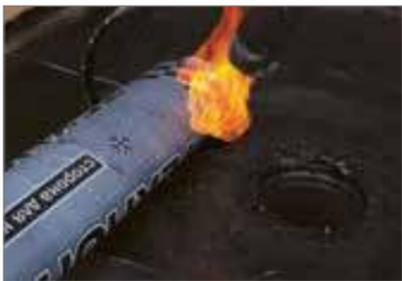
– Наплавьте нижний слой из материала Техноэласт ЭПП (см. п.3.2.1 «Наплавление нижнего слоя»). Боковой нахлест полотен должен проходить через ось воронки.
