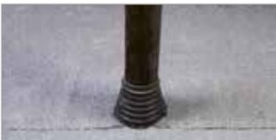
– Наплавьте верхний слой из материала Техноэласт ЭКП (см. п.3.2.2 «Наплавление верхнего слоя»).
