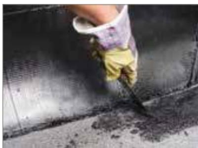
**!** **ВАЖНО!** Укладку дополнительного верхнего слоя Техноэласт ЭКП на вертикальную поверхность нужно начинать с пониженных участков кровли. Вода должна стекать со шва в сторону ендовы.
