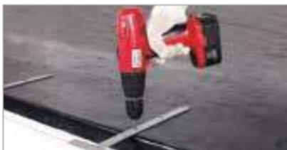
– **Т-образный кровельный костыль** – предназначен для крепления оцинкованных отливов и фартуков на парапеты. Металлический костыль должен быть толщиной не менее 4 мм.
