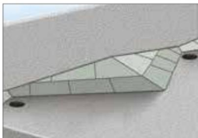
— Создайте дополнительный контруклон от вертикальных конструкций (стены, парапеты и т.п.) к водоприемной воронке (см. п.2.4. «Создание уклона на кровле»).
