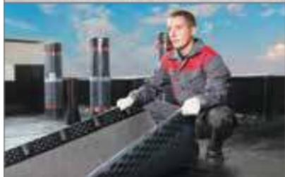
**!** **ВАЖНО!** В зависимости от уклона существует два способа намотки и раскатки рулона при наплавлении.
