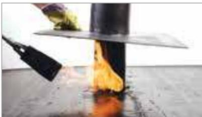
— Разогрейте пламенем горелки область материала для установки фланца стакана.
