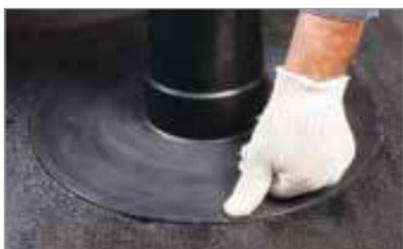
– Установите аэратор и вдавите юбку в разогретый материал. Следите за равномерным вытеком битумно-полимерного вяжущего из-под фланца аэратора. Вытек обеспечит полную герметичность соединения.
