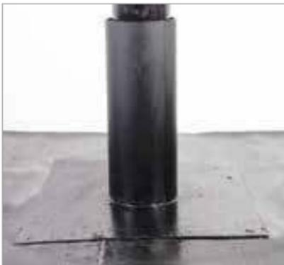
— Установите стакан и вдавите фланец в разогретый материал. Следите за равномерным вытеком битумно-полимерного вяжущего из-под фланца стакана. Вытек обеспечит полную герметичность соединения.
