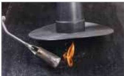
– Разогрейте пламенем горелки область материала Техноэласт ЭПП, на которую будет установлен аэратор.
