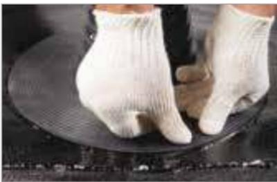
– Вдавите юбку в разогретый материал. Следите за равномерным вытеком битумно-полимерного вяжущего из-под юбки уплотнителя. Вытек обеспечит полную герметичность соединения.
