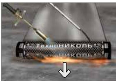
— Все поверхности, на которые будет наплавлен материал (вертикальные поверхности до высоты заведения материала и основание под пароизоляцию при сплошной приклейке), должны быть обработаны грунтовочными холодными составами (праймерами). В качестве грунтовки, наносимой на сухие поверхности, рекомендуется применять Праймер битумный ТЕХНОНИКОЛЬ № 01 и Праймер битумный эмульсионный ТЕХНОНИКОЛЬ №04.
