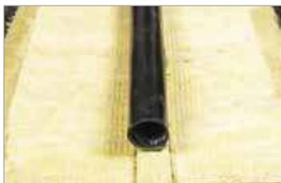
– Установите свернутый в трубочку материал Техноэласт ЭПП на сжимаемый утеплитель (ТЕХНОЛАЙТ). Диаметр трубы должен быть 50-70 мм.
