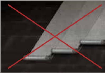
**!** **ВАЖНО!** Перекрестная наклейка полотнищ рулонов верхнего и нижнего слоев основного кровельного ковра не допускается!
