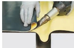
Для этого подготовьте полосу усиления из материала LOGICBASE V-SL, ширина которого должна «покрывать» расстояние от оси шва в обе стороны по **500 мм**. Разместите приготовленную полосу в области шва и точечно «прихватите» ее по одному краю для удобства дальнейшей работы.
