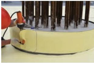
Сформируйте «отворот» нижнего края устанавливаемой полосы для формирования ее нахлеста на уже смонтированной по горизонтальной поверхности мембрани.
