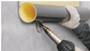
**Мембрану на фундаментной стене также можно крепить по временной схеме:** если рулон раскатывается не сверху вниз, а вдоль стены, рекомендуется выполнять временные крепления мембранны к стене из полос, вырезанных из ПВХ мембранны. Эти полосы следует срезать перед тем, как к мембране сверху будет приварен следующий ряд.
