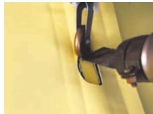
После того как проверочный канал «заглущен» посредством сварки, удалите неприваренную часть нахлеста для последующей установки заплатки.
