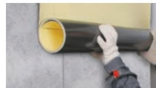
Обеспечьте не менее чем **100 мм** нахлест соседних полотен друг на друга. Сварите полотна мембранны между собой автоматическим сварочным аппаратом.
