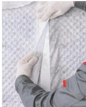
Установите краевой профиль выше уровня гидроизоляции, это предотвратит попадание грунта в зазор между гидроизоляцией и дренажной мембраной.
