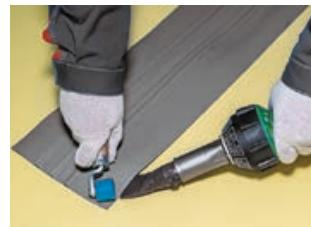
Насадку шириной **40 мм** поместите между свариваемыми поверхностями мембранны и гидрошпонки.
