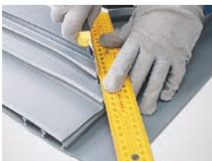
Подрежьте вначале только ребра гидрошпонки, а для резки плоской части уложите шпонку на ровную и прочную поверхность.
