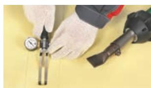
После окончания проверки герметичности шов выполните секционирование гидроизоляции и монтаж инъекционной системы. Подробнее см. п. **5.1.4. и 5.1.5**.
