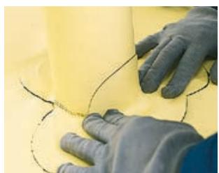
Приварите приготовленные заготовки, используя латунный прикаточный ролик, начиная от основания трубы и двигаясь к краям.
