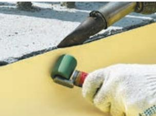
В местах раскрова материала на углах оголовка сваи установите усиливающие элементы в виде заплаток.
