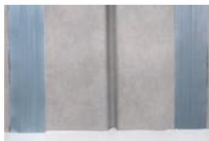
После снятия опалубки и подготовки поверхности бетона уложите первый слой геотекстиля.
