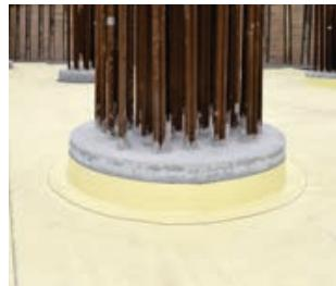
Такой способ примыкания к оголовкам свай требует тщательной подготовки основания для приклейки лент в части выравнивания и просушки.
