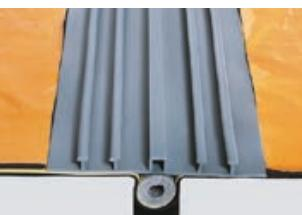
**ВАЖНО!** Не накрывайте анкеры гидрошпонки геотекстилем и пленкой. Анкеры должны быть открыты для последующего бетонирования.
