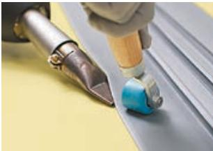
Используйте сварочный автомат «Варимат» для приварки плоского края гидрошпонок к мемbrane, если протяжённость шва большая.
