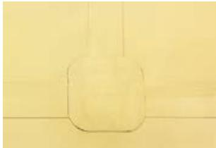
При механическом точечном повреждении гидроизоляции ее восстановление следует производить наложением заплат размером не менее 120 мм в диаметре. При этом расстояние по всем направлениям от места повреждения до края заплат должно быть не менее 50 мм.
