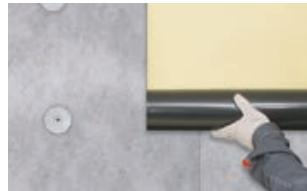
По мере раскатки мембранны приварите ее к ронделам, которыми предварительно был закреплен первый слой геотекстиля.
