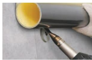
Сварите между собой полотна гидроизоляционной мембранны автоматическим сварочным аппаратом.
