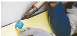
ТЕХНОНИКОЛЬ (см. п. 3.2 настоящего раздела). После того как лента установлена на поверхности бетона, герметично приварите мембрану LOGICBASE V-SL к ее поверхности.
