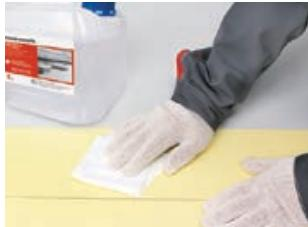
Выполняйте сварочные работы только на чистых и сухих поверхностях мембраны. Удалите со свариваемых поверхностей грязь и пыль при помощи влажной ткани, смоченной очистительным составом для ПВХ мембран **ТЕХНОНИКОЛЬ**.
