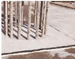
Примыкание гидроизоляционной мембраны к сваям может быть выполнено при помощи kleевой шпонки. В этом случае в опалубку гидрошпонка не устанавливается. После отливки оголовка вокруг сваи и снятия опалубки ПВХ ленту ТЕХНОНИКОЛЬ следует при克莱ить на поверхность гидробетона при помощи эпоксидного клея ТЕХНОНИКОЛЬ. Мембрана приваривается к kleевой шпонке аналогично тому, как это было описано в предыдущем разделе.
