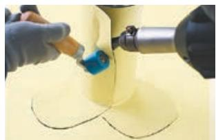
После того как «лепестки» приварены к основной мембране, сварите образовавшийся нахлест на трубе.
