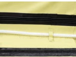
Компенсатор напряжений из экструзионного пенополистирола выполнять в виде бруса 50×50 мм. Крепление компенсатора напряжений к поверхности полимерной мембранны осуществлять при помощи предварительно приготовленных полосок из применяемой полимерной мембранны с последующей приваркой их к поверхности гидроизоляционного покрытия.
