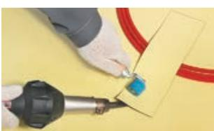
Для удобства монтажа трубок закрепите их на поверхности мембранны небольшим «хлястиком» мембранны.
