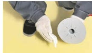
Ручным аппаратом точечно приварите фланец штуцера к поверхности мембранны.
