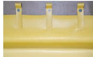
При монтаже следующего ряда мембранны обеспечьте нахлест между нижним и верхним рядами мембранны не менее **100 мм**.
