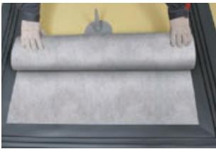
**ВАЖНО!** Не укладывайте геотекстиль на гидрошпонки, их анкеры должны быть открыты для последующего бетонирования.
