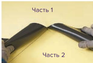
Совместите край разреза первой части с нанесенной разметкой второй части элемента, формируя при этом нахлест для сварки.
