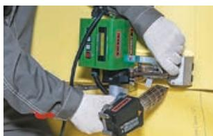
По мере движения аппарата удаляйте временное крепление в виде полос, отрезая их от механического крепления и в области «прихватки».
