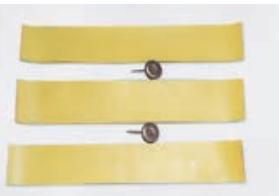
Механически закрепите полосы на стене выше верхнего края мембранны на **10–15 см**. Точечно «прихватите» мембранны к полосам ручным аппаратом.
