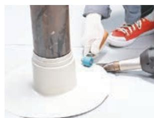
Приварите «юбку» готового элемента по «кругу» с помощью тефлонового или силиконового прикаточного ролика.
