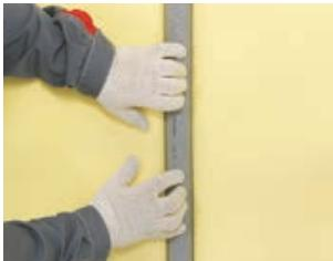
Установите полосу из мембранны **LOGICBASE V-SL**, по ширине превышающую ширину шва на **150–200 мм**, в каждую сторону.
