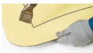
Строительным феном разогрейте небольшой участок заготовки в месте скругления. Когда мембрана станет мягкой, растяните ее руками.
