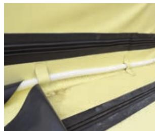
После установки компенсатора следует смонтировать слой усиления гидроизоляционного покрытия путем кладки в месте установки компенсатора дополнительного слоя мембранны шириной не менее 300 мм. Слой усиления должен быть установлен по всему периметру края фундаментной плиты, а его ширина при установке должна равномерно распределиться относительно края плиты в обе стороны.
