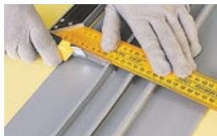
В месте каждого реза сформируйте «галочки» по ширине, равной высоте ребра гидрошпонки.
