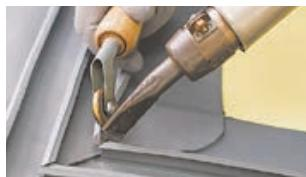
После того как плоские части гидрошпонок сварены между собой и приварены к гидроизоляционной мемbrane, выполните сварку ребер гидрошпонок.
