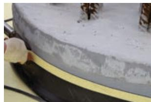
Приварите сформированный ранее «отворот» к уже смонтированной по горизонтальной поверхности мембрани.
