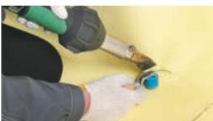
Тщательно проварите оставшуюся площадь заготовки. Используйте широкий силиконовый ролик.
