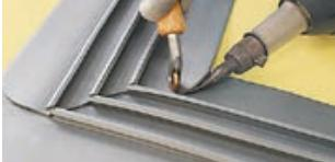
Приварите плоские края гидрошпонок друг к другу, используя латунный ролик.
